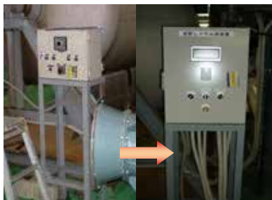
制御盤リニューアル(自動運転機能付加)
