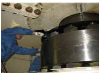
水車点検状況
