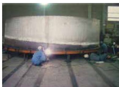
200m 3タンク製作状況
