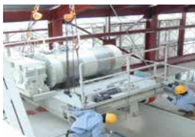
天井クレーン据付
