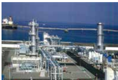
JX喜入石油基地(株)殿向 タンカー-排出処理設備建設工事
