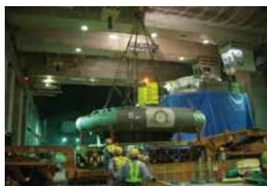
水車ランナ吊り込み
