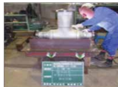
配管加工状況
